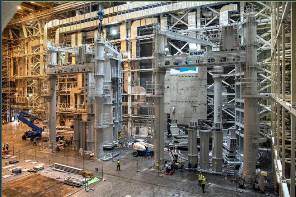
Fournis par la Corée, ces portiques géants sont conçus pour préassembler secteurs de chambre à vide, bobines verticales (TF) et section d'écran thermique. Ils peuvent manipuler des charges de l'ordre de ~ 1 500 tonnes.
