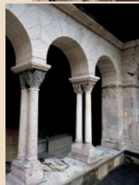
Cloître Saint-André-le-Bas en cours de restauration
