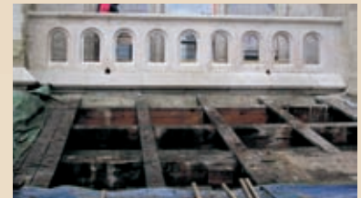
Etais dans les combles du bas-côté Nord
