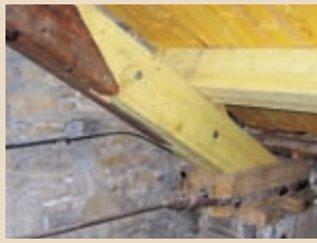
Reprise d'un élément d'une ferme (Nef)
