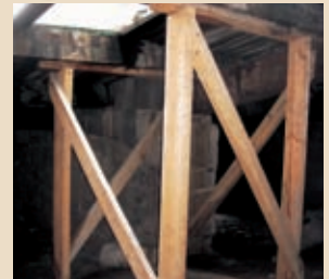
Etais dans les combles du bas-côté Nord
