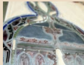
Détail d'un vitrail déposé en cours de restauration
