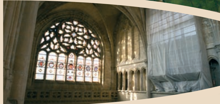
Verrière occidentale datée du 20 e siècle
