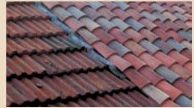
Toiture de la nef : les tuiles neuves côtoient les tuiles mécaniques
