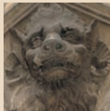
Sculpture d'une fenêtre haute avant restauration
