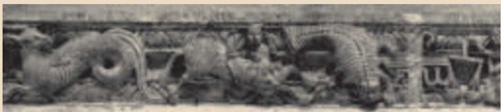
Combles du Bas-côté Sud
