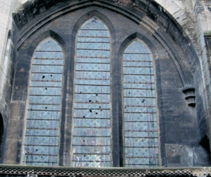
Fenêtre haute détériorée de l'élévation Nord de Saint-Maurice
